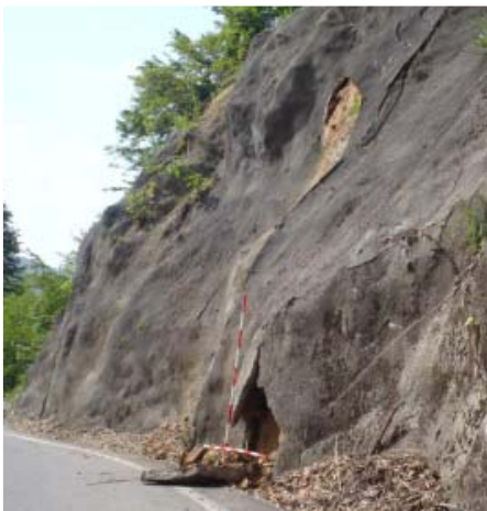
《モルタル吹付のり面の老朽化状況》 モルタル・地山の劣化により、剥落・崩落が発生
