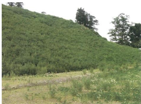
バイオプラスターチ吹付工法による緑化
