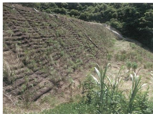
バイオ・植生注入マット工法によるモルタル法面の緑化
