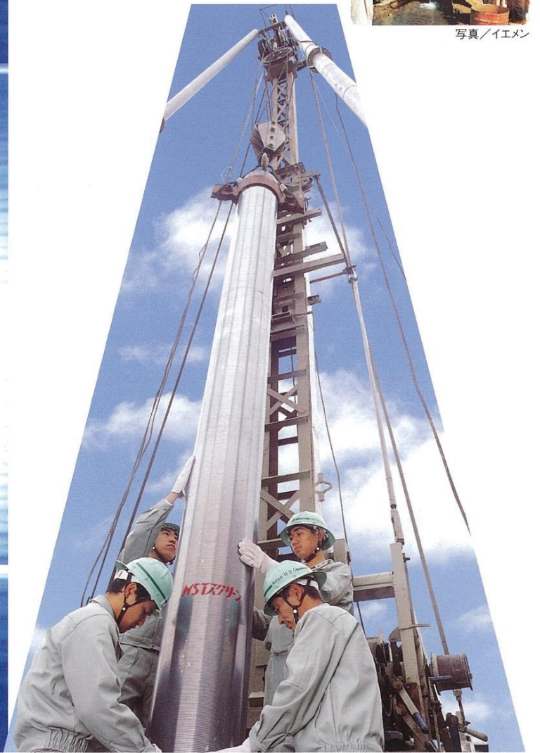
NSTスクリーンの設置状況
