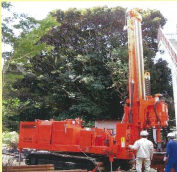
ソニックドリルを用いたケーシング管抜管作業の状況
