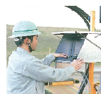
NSCPTによるデータ計測
