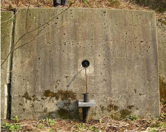
《アンカー破損状況》
