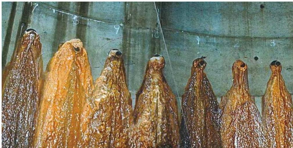
《水抜きボーリング孔の機能低下状況》
