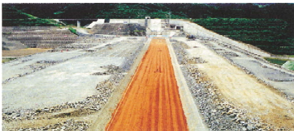
ロックフィルダムの築造例
