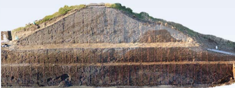
図-2 デジタルカメラ撮影の写真より作成したのり面の高解像度オルソ画像
