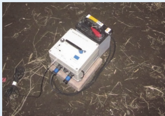
写真-2 地表計設置状況 (例)
