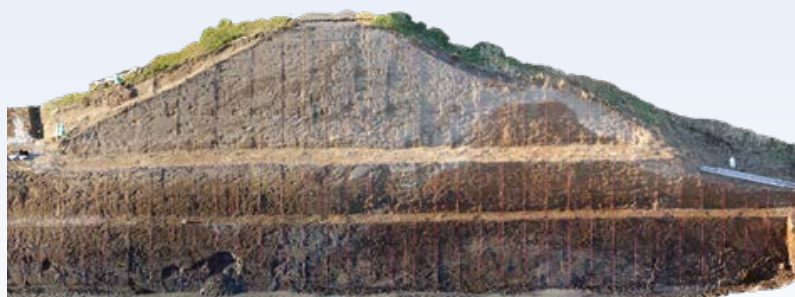
図-2 デジタルカメラ撮影の写真より作成した法面の高解像度オルソ画像
