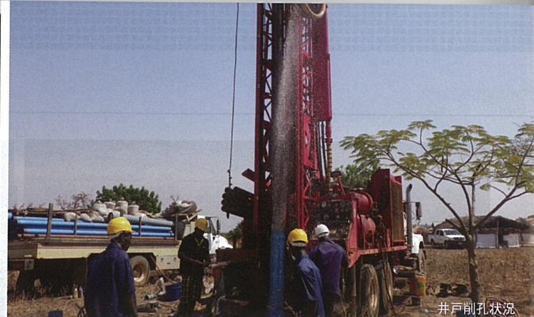
井戸削孔状況
