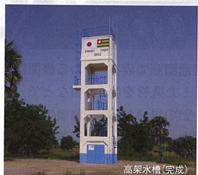
高架水槽(完成)
