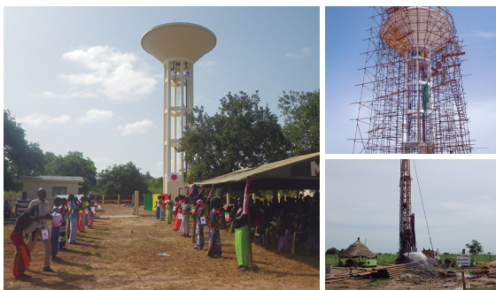
「シャトー・ドー」と呼ばれる独特なセネガルの高架水塔。竣工式(左)と工事中(右)の様子
