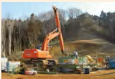
集水井掘削状況
