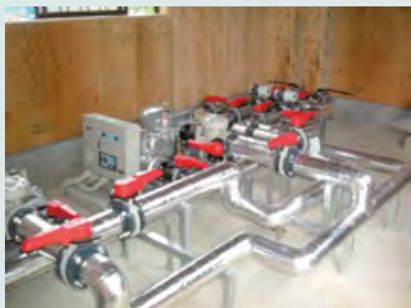
送湯配管設置状況
