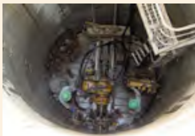
集排水ボーリング削孔状況
