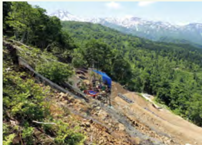
山間地で発生した斜面崩壊の 原因を把握する地質調査
