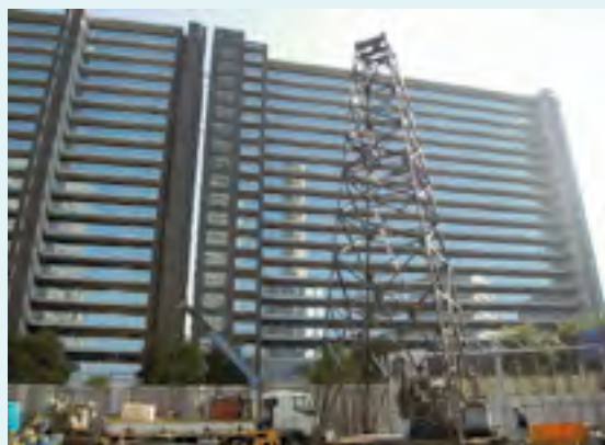
埼玉県 ビル用水水源井戸 200A × 280m 掘削状況
