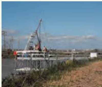
各種の構造物を支持させるための 地層を把握する地盤調査
