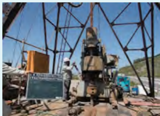
群馬県 工業団地水源井戸 250A × 250m 掘削状況
