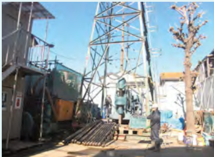
埼玉県 水道水源用井戸 300A × 213m 掘削状況
