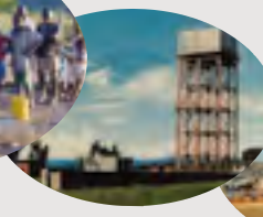
ネパール(1980年) ＜給水塔＞
