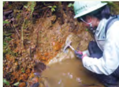
地質状況を把握するための 地質調査
