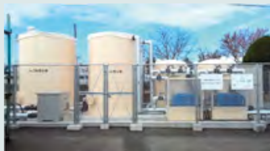
排水再利用ろ過設備 (最大送水能力 60m 3 /H 排水再利用システム)
