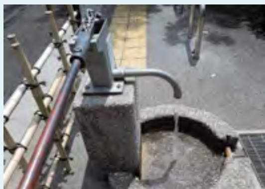
東京都 非常災害用井戸 ハンドポンプでの揚水状況
