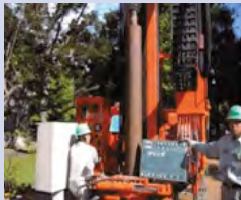
既設ケーシング抜管状況
