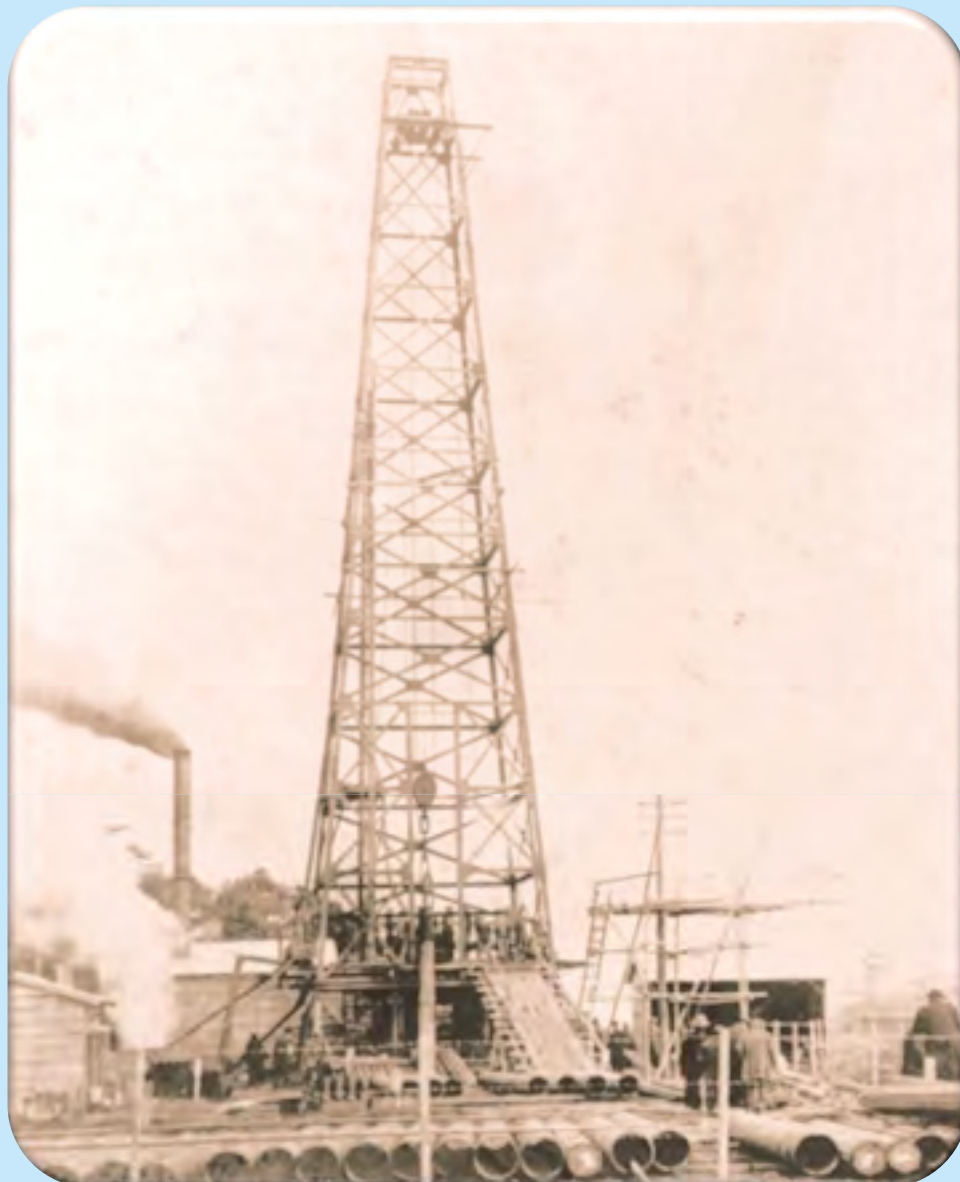
日本初の機械掘りによる 井戸掘削工事 (東京・下落合 大正2年)
