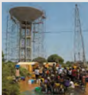
セネガル(2012年) ＜給水塔と井戸掘削＞
