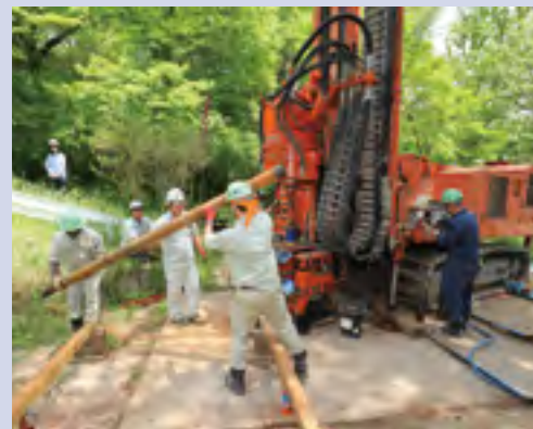
RWケーシング抜管状況
