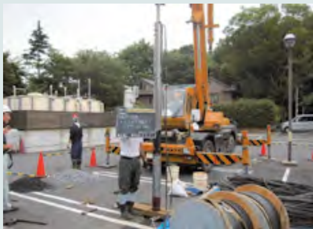
深井戸用水中モータポンプ設置状況
