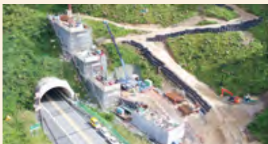
システム作業構台を用いた大口徑ボーリングマシン工法
