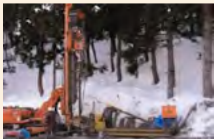
削孔状況(ソニックドリル)
