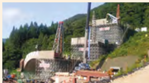
システム作業構台を用いた大口徑ボーリングマシン工法
