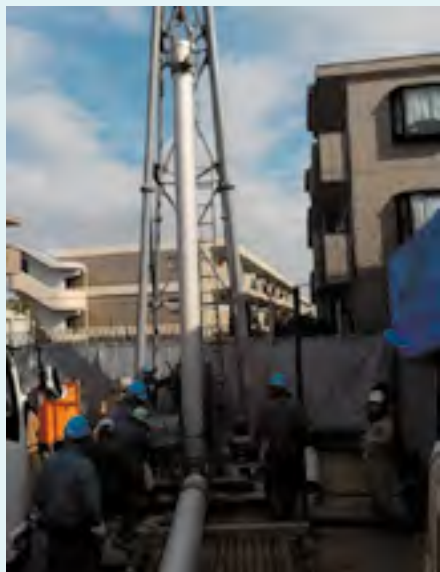
東京都 水道水源用井戸 300A × 200m ケーシング挿入作業
