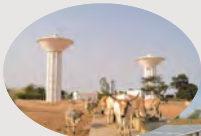
セネガル(2012年) ＜給水塔＞
