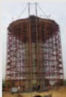
ベナン(2018年) ＜給水塔＞
