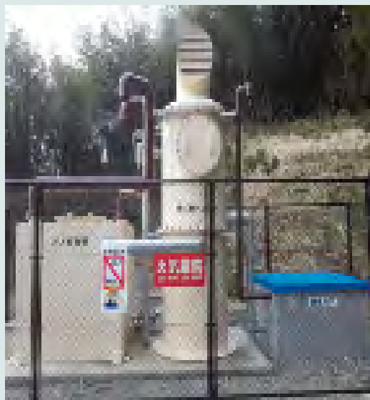
温泉用貯湯槽・ガスセパレータ設置状況
