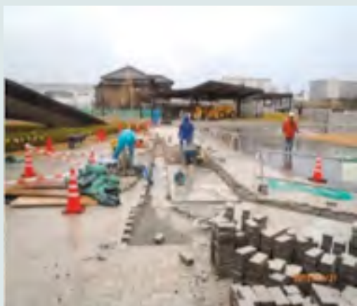
融雪パネル設置状況
