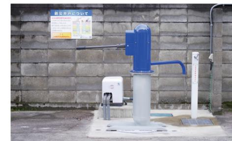
図3 新デザインの手動ポンプ試作品
