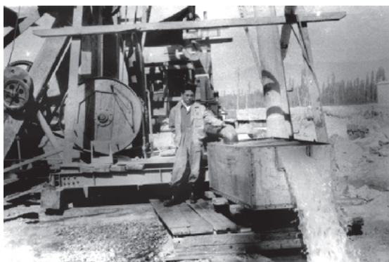
【アフガニスタン共和国カブール市・ヘラート市 水道水源井工事（1958年）】
