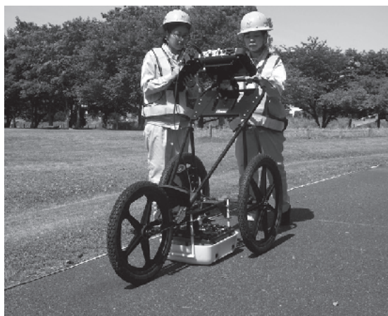
地中レーダーによる調査
