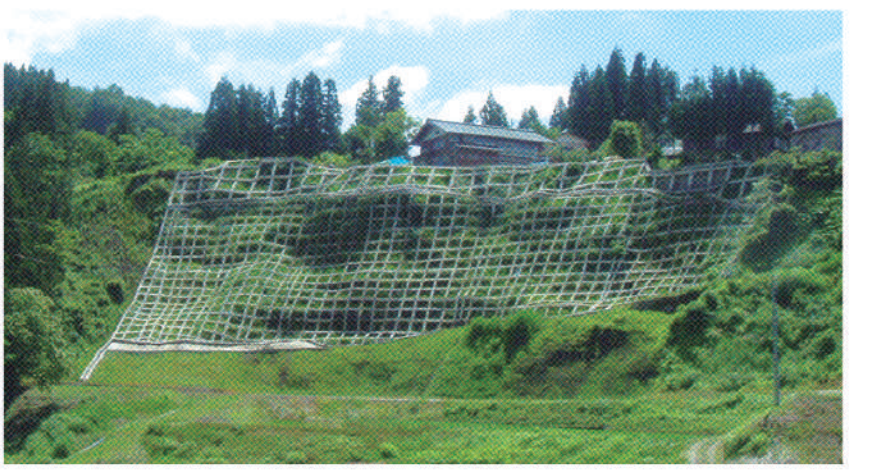
特殊土木工事
