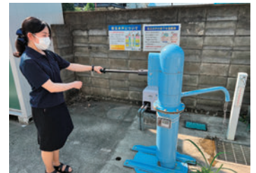
▲敷地内に設置された防災井戸。力いらずで簡単に汲みだすことができる
