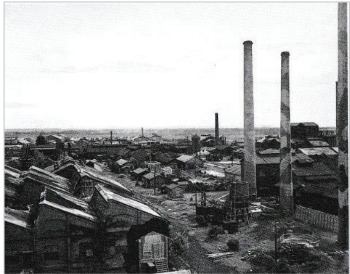
写真③第二工場第一汽缶場付近
