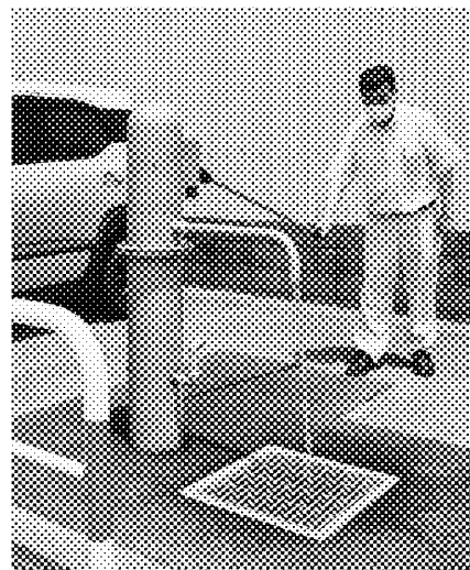
日さく上越支店内に完成した防災井戸。ステンレス表面をプラスチック処理して現代風のデザインにした
